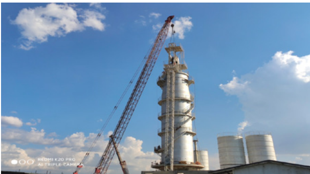
图 | 中资清洁石灰厂安装项目
