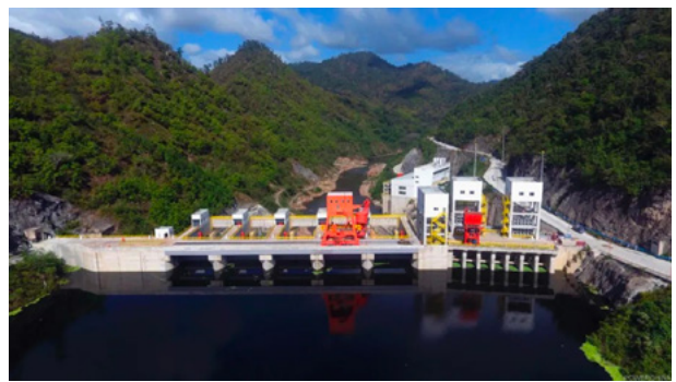
洪都拉斯帕图卡 III 水电站
