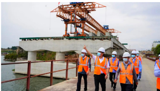
刘为民在调研马古富力大桥时向施工人员致敬
