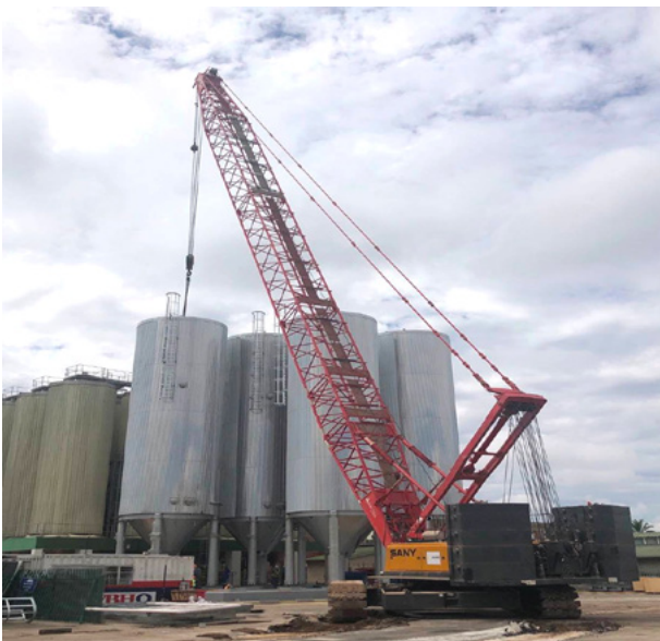
图 | 卢萨卡啤酒厂储罐吊装
