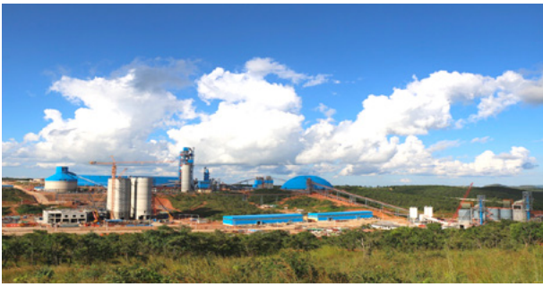
图 | 2018 年投产的中国建材工业园 EPC 项目
