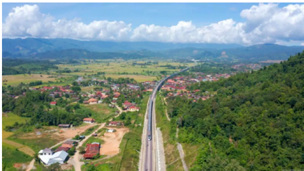
中国电建承建的中老铁路卡西段
