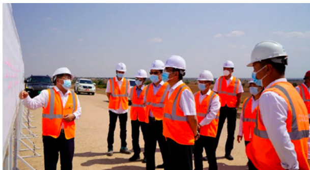
调研中央线标轨五标现场
