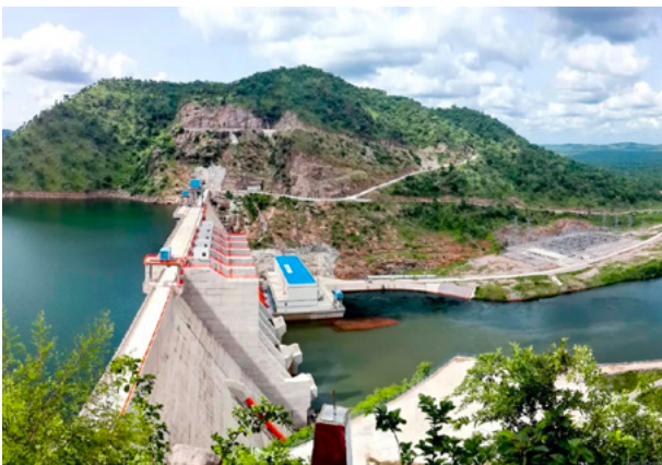
加纳布维水电站项目
