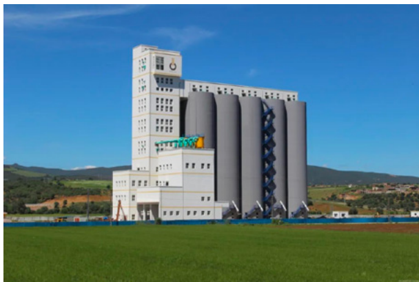
阿尔及利亚九个混凝土粮仓项目荣获国家优质工程奖
