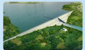
赞比亚KAFULAFUTA供水系统项目
