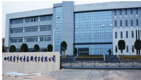
四川遂宁利普芯微电子集成电路研发项目
