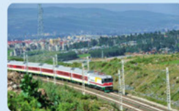
埃塞吉布提铁路项目
