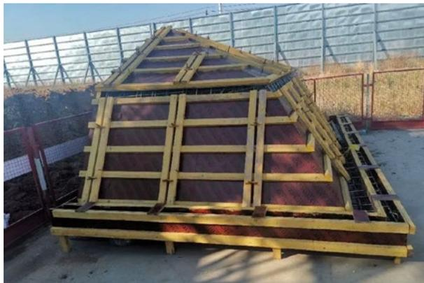
本着一丝不苟的匠人精神，制作了5:1屋面模型，经过多次试验确定混凝土坍落度，最后确定陡坡段混凝土坍落度为150mm，缓坡段混凝土坍落度为140mm，通过下部陡坡段施工采用双面模板的方式，提高陡坡混凝土浇筑质量。
